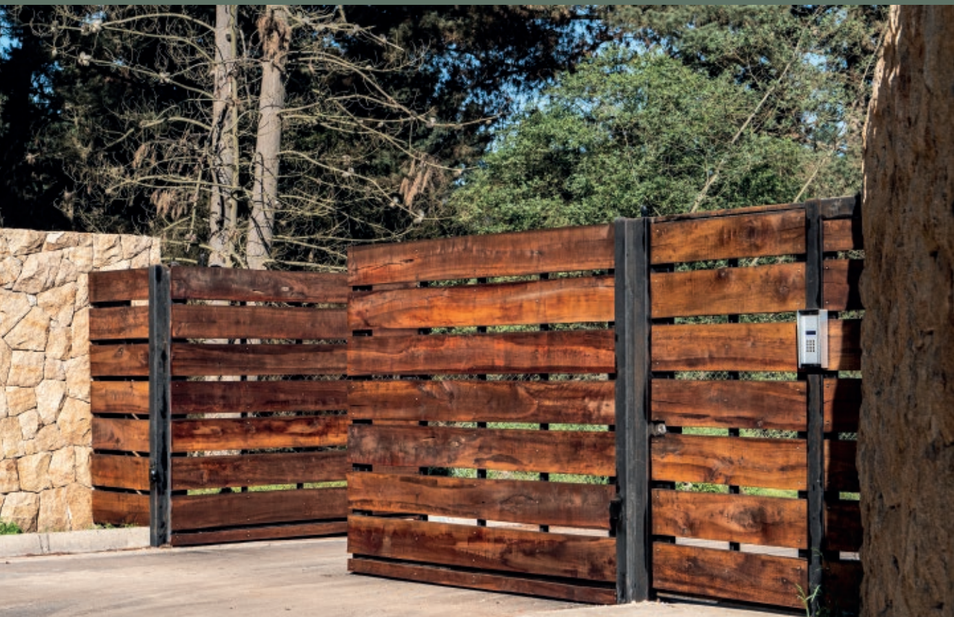
PORTÓN DE ACCESO AUTOMÁTICO
